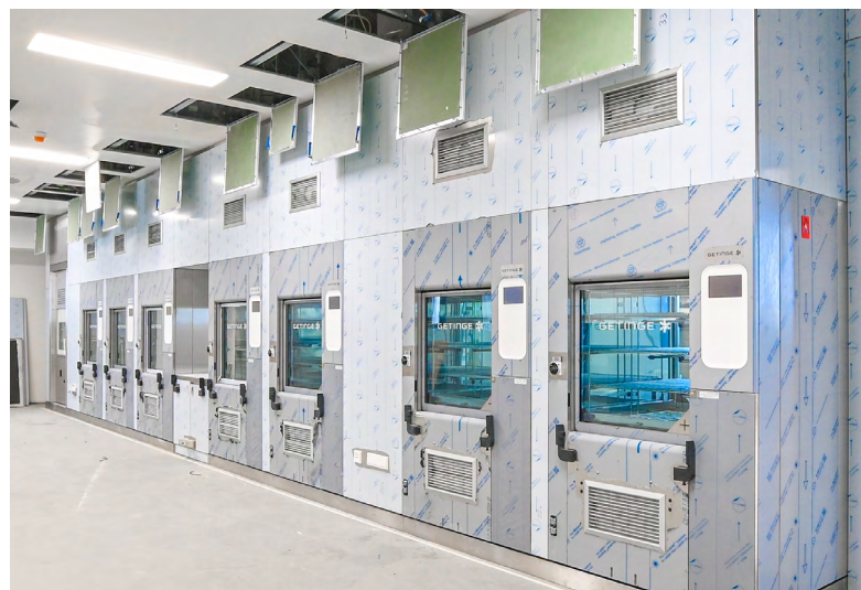
Reinigungs- und Desinfektionsgeräte in der Zentralen Sterilisation
