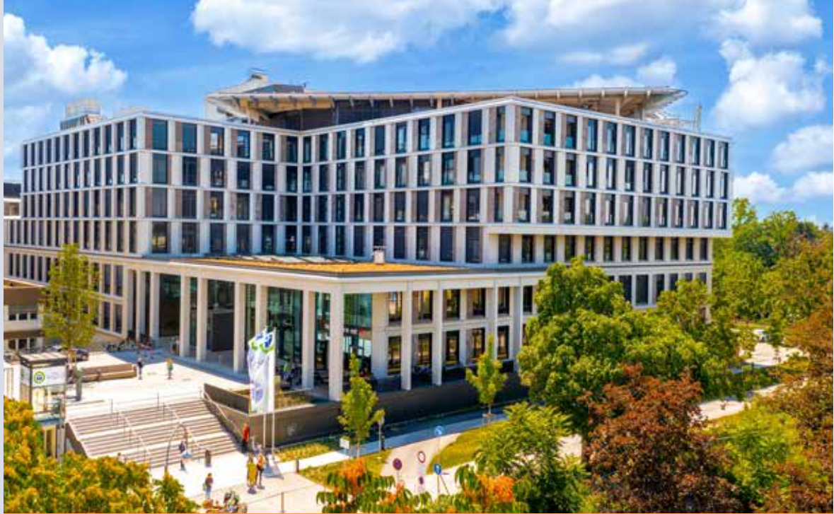
Der Neubau der ViDia Kliniken in der Steinhäuserstraße im Juli 2022
